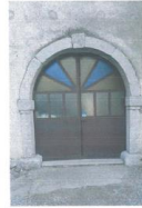
4. le obstoječi vhod
